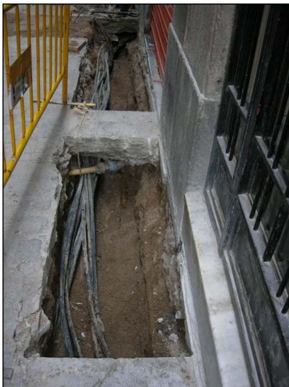
51. Tram de la rasa al carrer de la Lleona a la façana oest.
