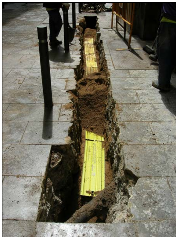
39. Col·locació de part de la instal·lació elèctrica.
