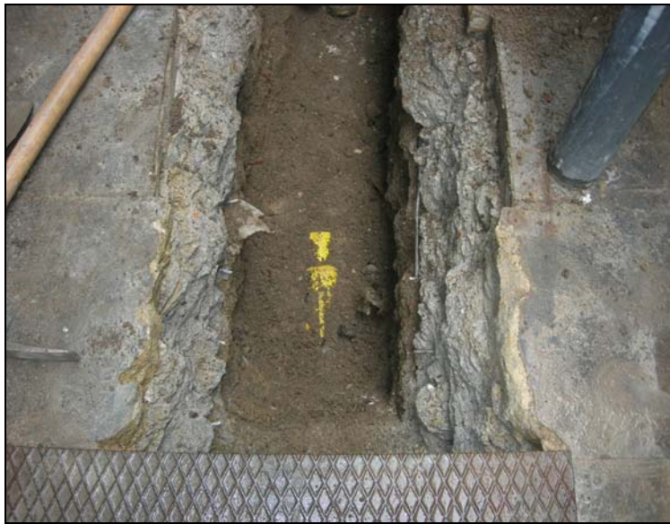
35. Detall de connexió elèctrica a l'alçada del Passatge del Crèdit.
