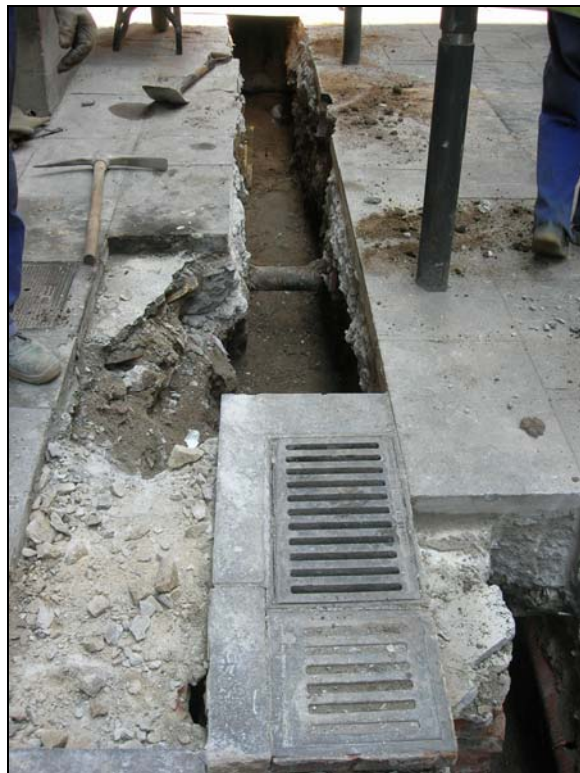
42. Arqueta localitzada a l'alçada del nº5 de la Baixada de Sant Miquel.
