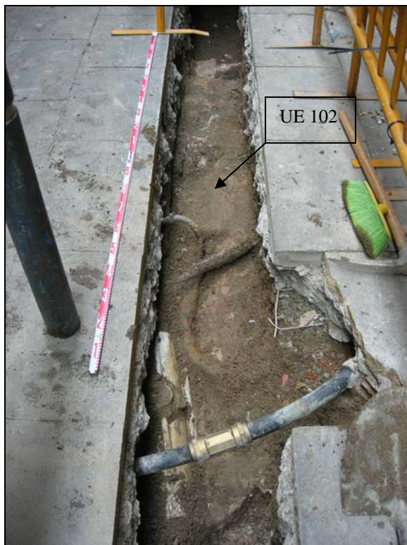
15. Restes de la muralla romana amb diversos serveis.
