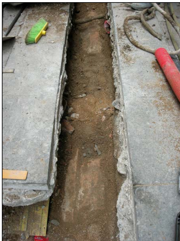
31. Cobriment amb geotèxtil de les estructures localitzades.
