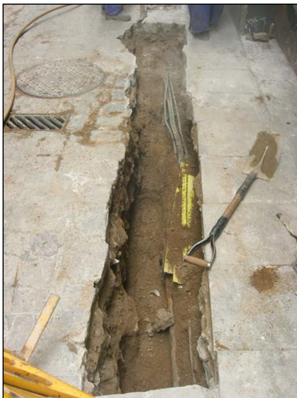
49. Tram de la rasa al carrer de la Lleona a la façana oest.
