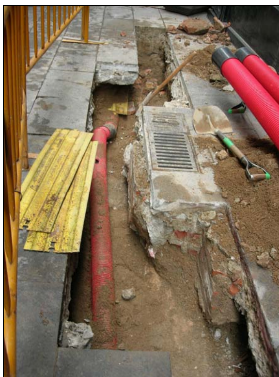
30. Instal·lació de tubs.
