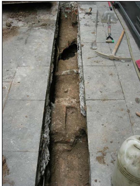
28. Vista general de la claveguera que es trobava en funcionament.
