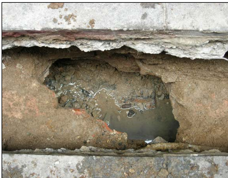
29. Detall de la claveguera activa.
