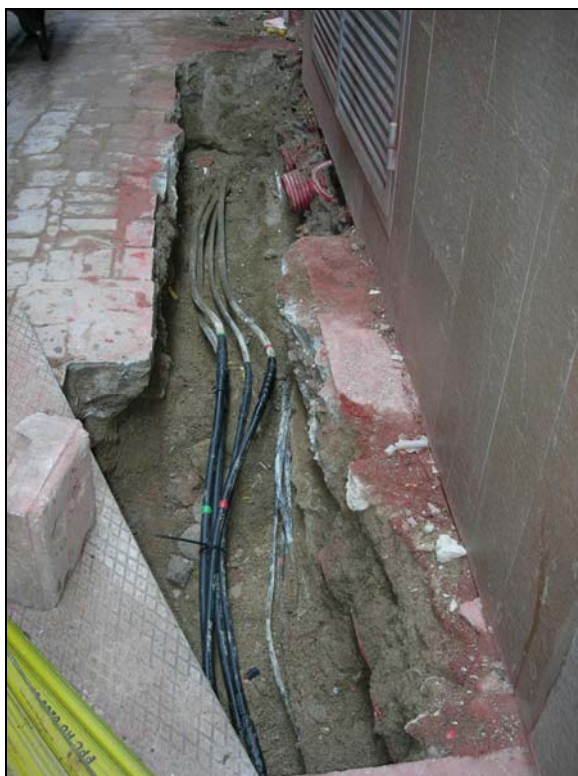
2. Inici de la rasa al C/ Lleona nº 13.
