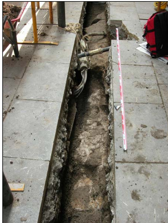
20. Vista del conjunt d'estructures.
