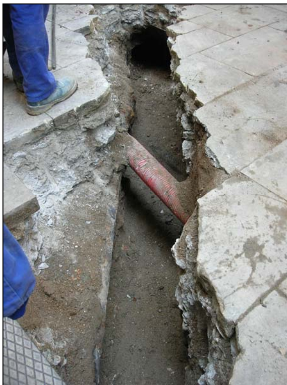
43. Tram en diagonal per enllaçar amb la zona estreta del carrer.
