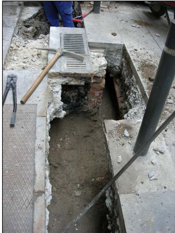
41. Arqueta localitzada a l'alçada del nº5 de la Baixada de Sant Miquel.
