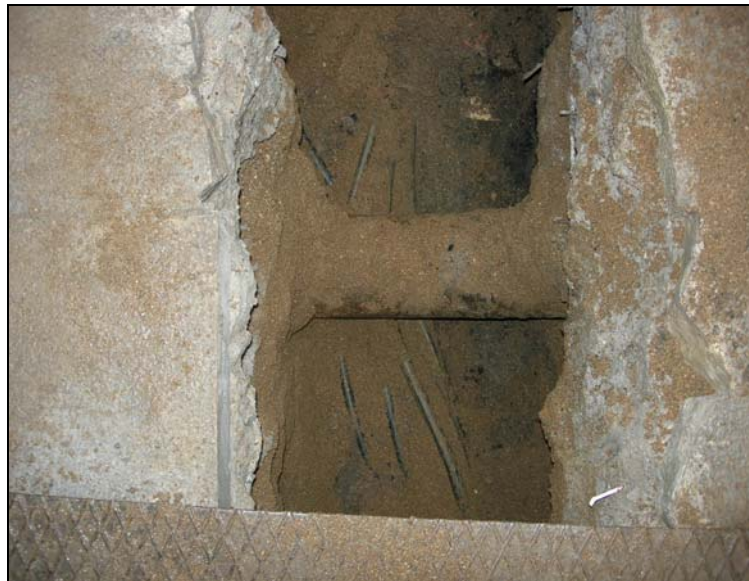
37. Detall de la gran quantitat de serveis elèctric a 70cm de la superfície, davant el Passatge del Crèdit, juntament amb la canalització d'aigua potable.
