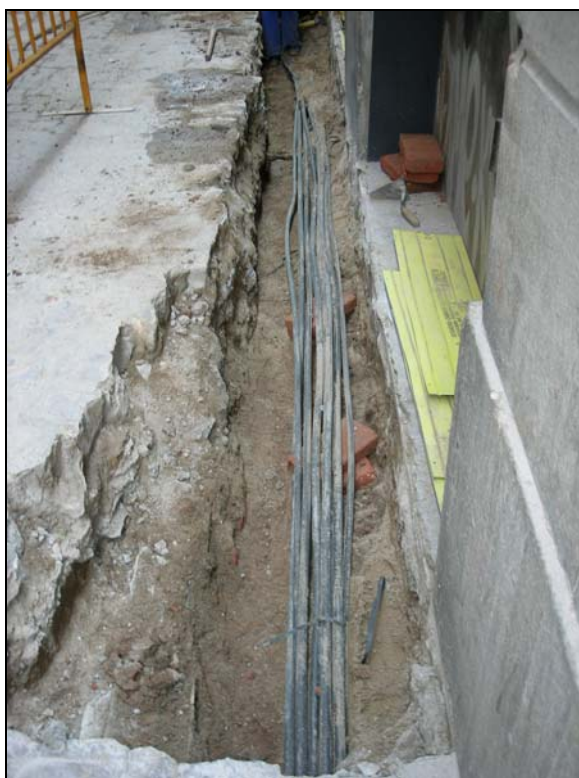
50. Tram de la rasa al carrer de la Lleona a la façana oest.
