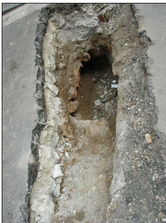
6. Cala realitzada a l'encreuament del c/ Avinyó amb la Bda. de sant Miquel
