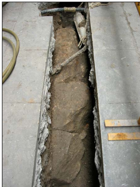
22. Vista general del tram de muralla romana.
