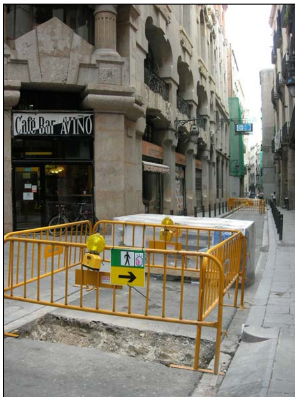
7. Vista del C/ Avinyó un cop realitzades les cales de comprovació.
