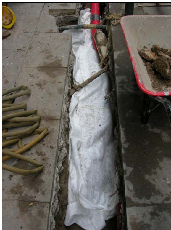
31. Cobriment amb geotèxtil de les estructures localitzades.
